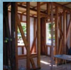
Cuisine en construction
