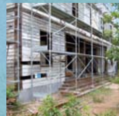
Rénovation de la façade
