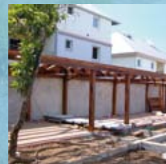
Longère en travaux
