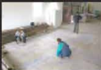
Les éléments de l'ossature bois sont mis sur épure par les compagnons.
