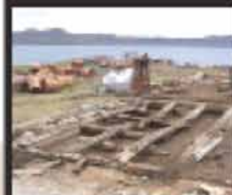
Démontage systématique jusqu'aux lambourdes...
